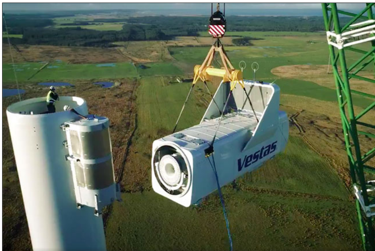
Obrázok 4: Postup pri výstavbe veternej elektrárne – montáž gondoly
